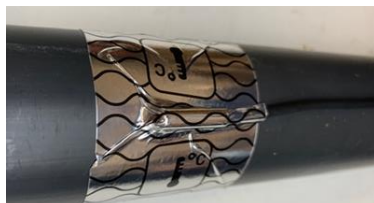
Figura 4 – Instalação da Sonda de Temperatura
